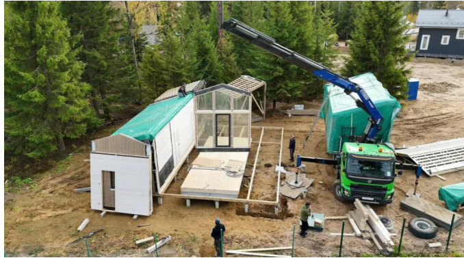
Рисунок 1 – Монтаж модульного дома https://chalett.ru/tpost/jjt5jz5re1-v-etot-prekrasnii-solnechnii-denyok
